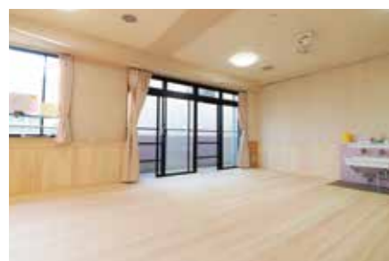
東大阪市 本庄こども園様 2階教室改修工事/大阪府内産木材使用/床・腰壁
