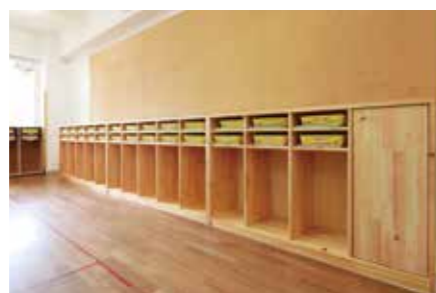
枚方市 清香学園幼稚園様 教室改修工事/大阪府内産木材使用/ ロッカー・収納BOX・腰壁建具
