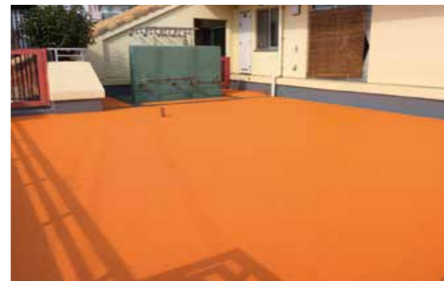
大阪市住之江区 安立保育園様 テラスシート工事
