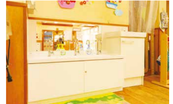
大阪市住吉区 こぐま保育園様 手洗い入替工事
