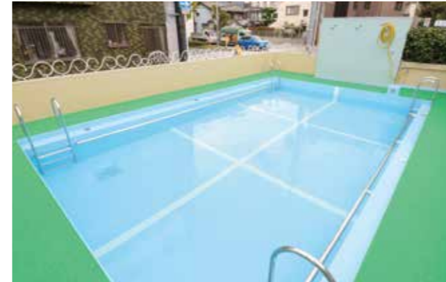
大阪市東住吉区 平和幼稚園様 プール防水改修工事
