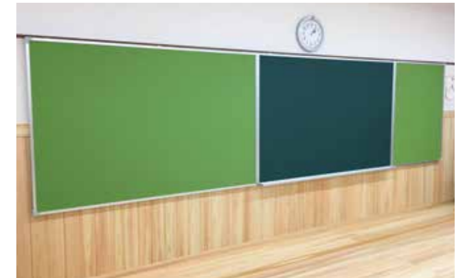
大阪市城東区 野江幼稚園様 木質化同時施工 黒板入替工事
