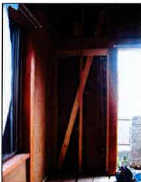
▼筋交いの設置
